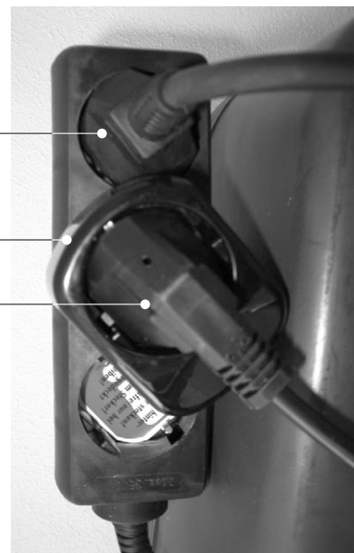
Bild 8 Elektrischer Anschluss der Box V25K
